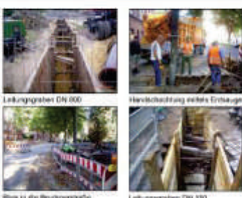
Leitungsgraben DN 800, Handhabung mittels Erdtauger
