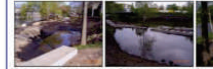
Baufortschritt der Parkanlage | Einbau der Fertigbauwerke / Arbeiten
