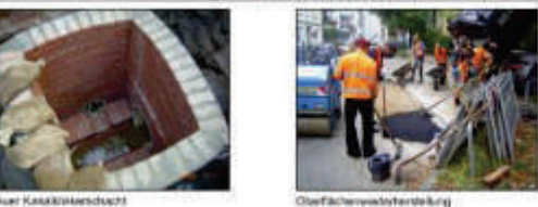
Neuer Kanalbauwerk, Oberflächenwasserleitung
